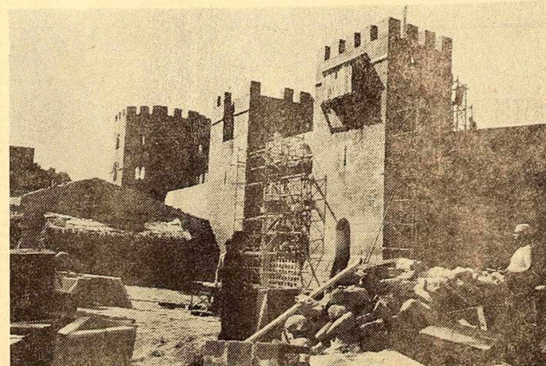
Una vista interior del recinto amurallado. Los trabajos continúan a fuerte ritmo. (Foto Zubietta).
